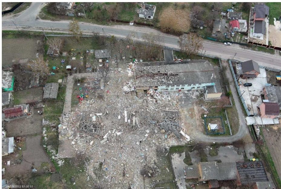
Рис 5.1. Зруйнований ЗДО «Барвінок»
